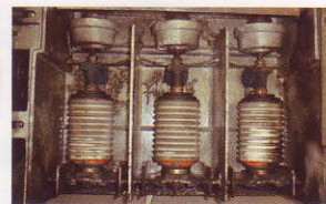
結露により短絡事故となった真空遮断器(CB形)
