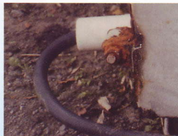
機器の底面: 機器の底面周辺で、錆による腐食が進み、気密不良のおそれがある状態
