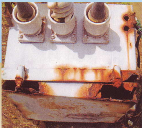
経年劣化により、錆が発生（施設後約15年経過）
