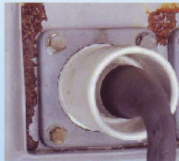
ブッシング取付金具部: 本体とブッシング取付金具の合わせ面が著しく錆びている状態
