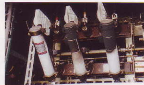
短絡事故となった限流ヒューズ付き高圧交流負荷開閉器(PF・S形)
